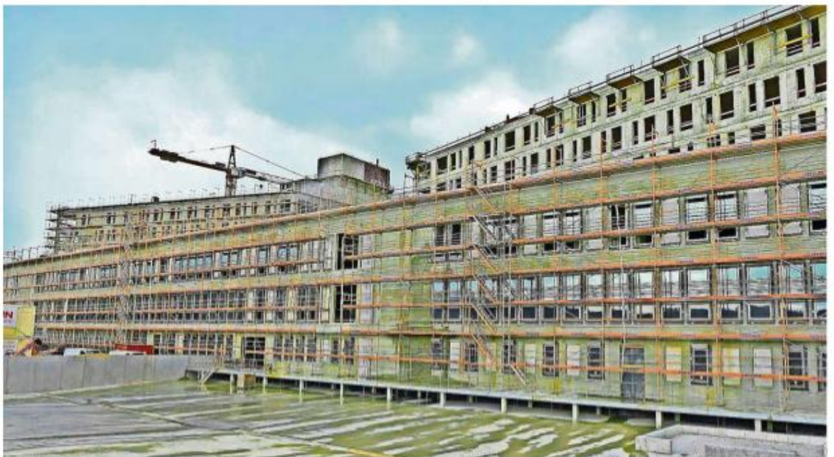
Das Zentralklinikum soll Ende 2025 seine Türen öffnen.
